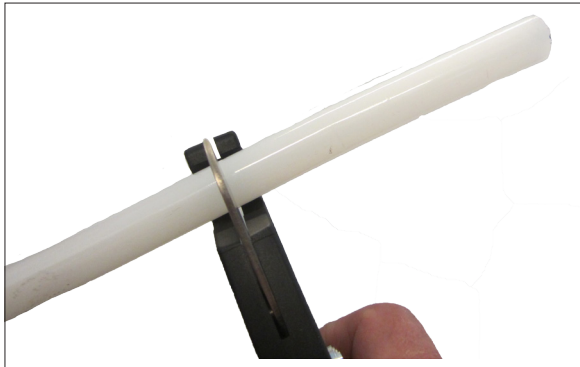
PEX och PE-RT-rör kortas vinkelrätt med en PEX/PE-RT sax.
